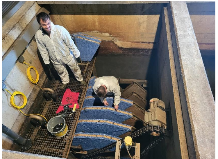
Remplacement des toiles de filtres
