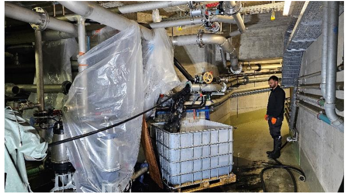
Curage conduite épaisseur
