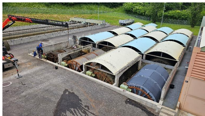
Remplacement des disques biologiques
